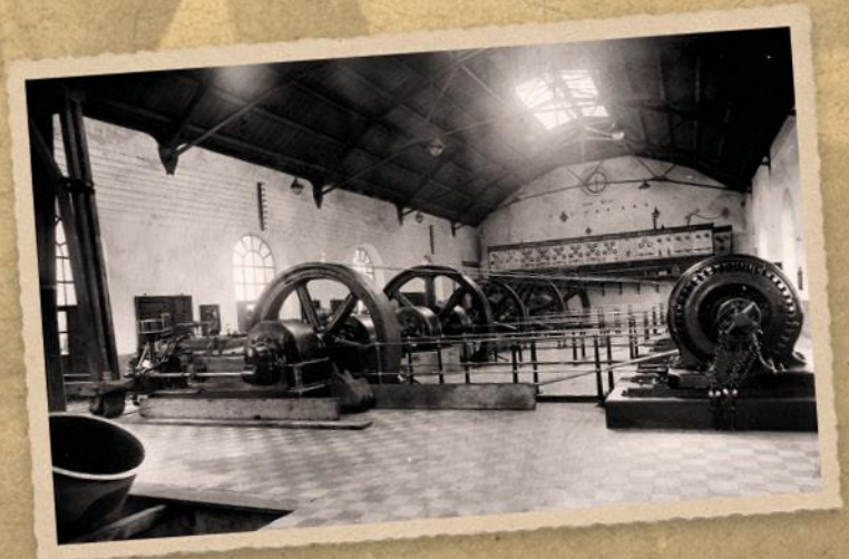
Centrale Elettrica 1909 – Birificio 4 Mori 2013
